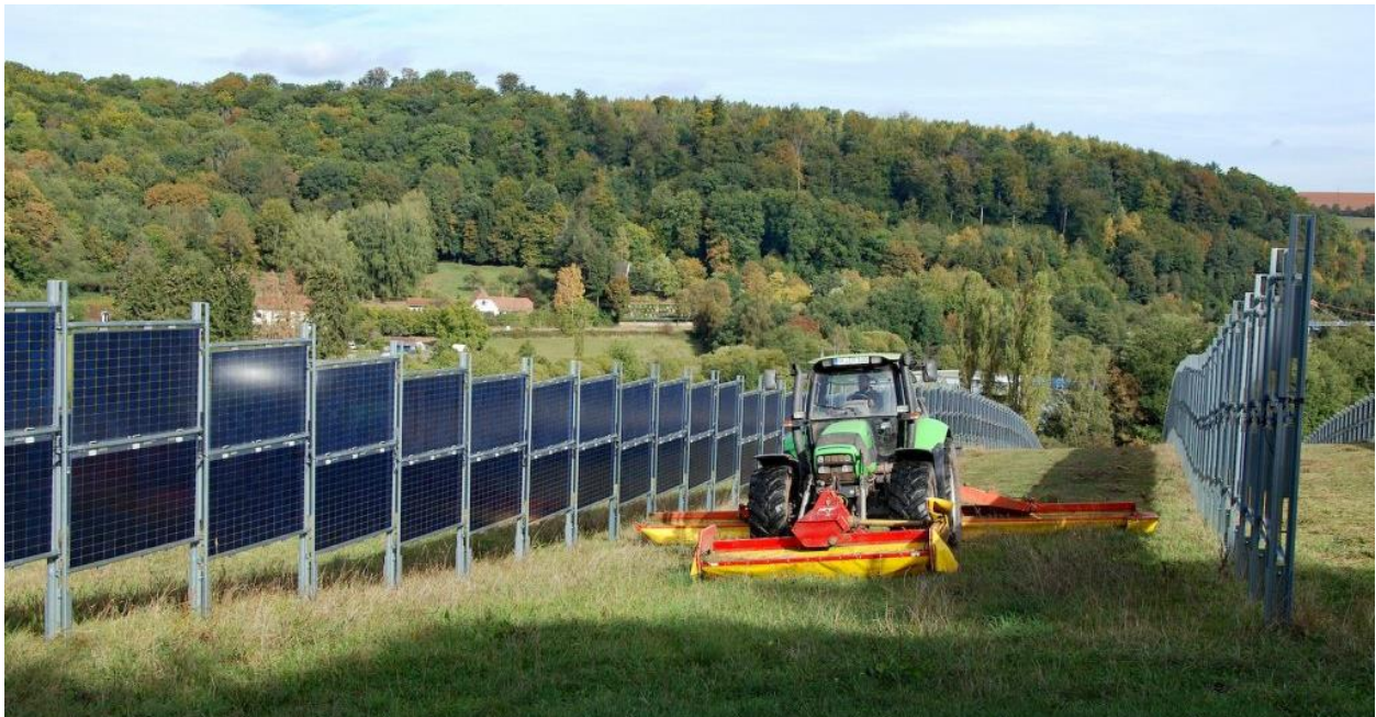
Abb. 1: Foto einer bifacialen Freiflächenphotovoltaikanlage, Quelle: www.next2sun.de
